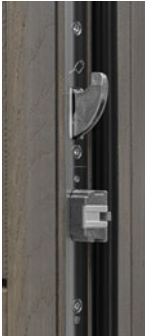
Zoom crochet sécurité et pêne serrure automatique
