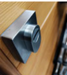
Vue rosace renforcée et traversante, face extérieure
